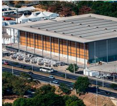
ARENA DE DEODORO
